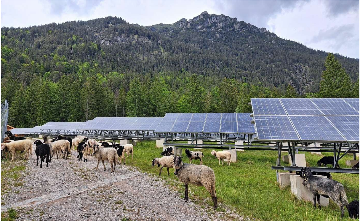
PV-Anlagen „Am Lachen“, ehemalige Mülldeponie, unterhalb des Kramers.
